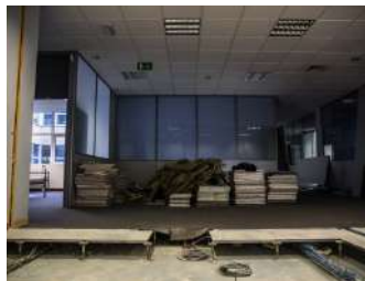
DÉBUT DES TRAVAUX PORTE D'ULYSSE 3
